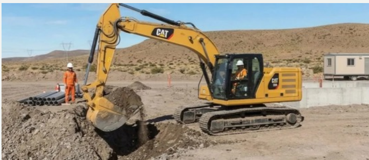
Excavadora hidráulica Caterpillar 320
