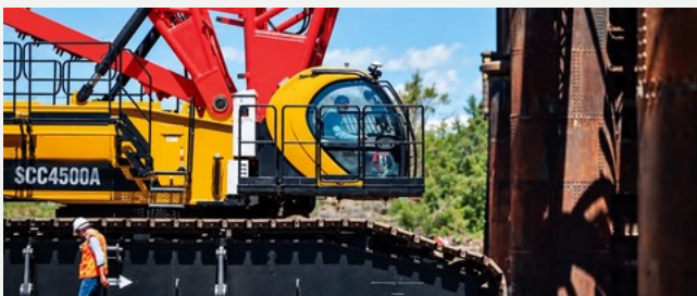
Grúa sobre orugas
